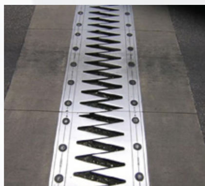
Khe co giãn răng lược – Finger joint
